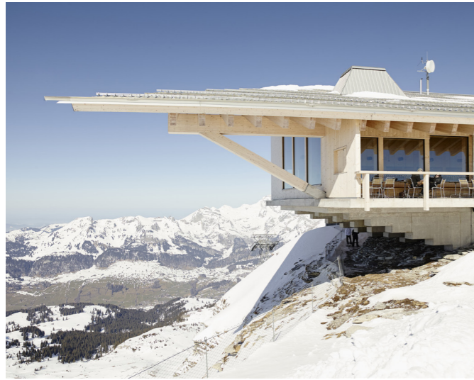
Chäserrugg, 2014-15, Pirmin Jung Ingenieure, Architekt Herzog de Meuron
